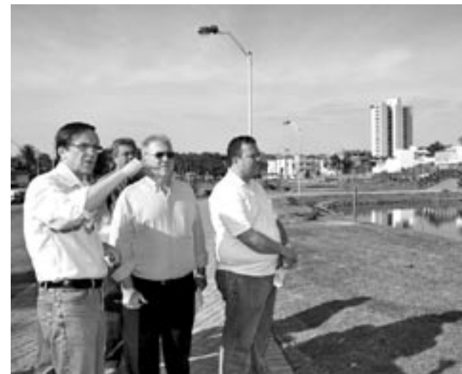
GOMIDE e vereadores visitam obras do Parque Ipiranga, no Jundiá
