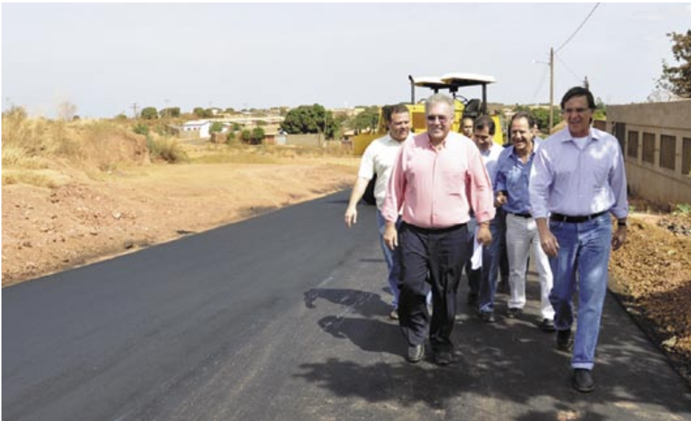
ANTÔNIO GOMIDE e comitiva percorrem obras de pavimentação no Jardim Alvorada; a previsão de entrega do asfalto em todo o setor é em setembro
