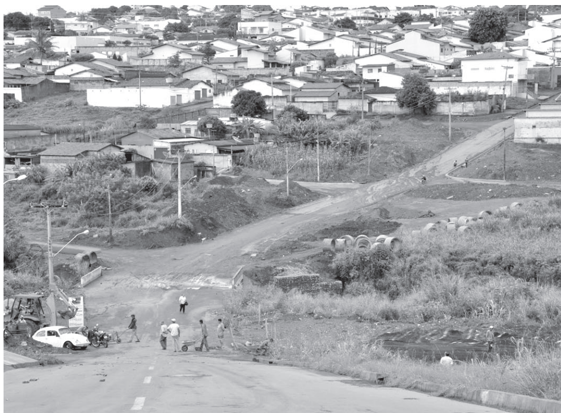
RUA PÉROLA e vias próximas ganham galerias para evitar o que aconteceu na gestão passada: em 15 dias obra ruiu
