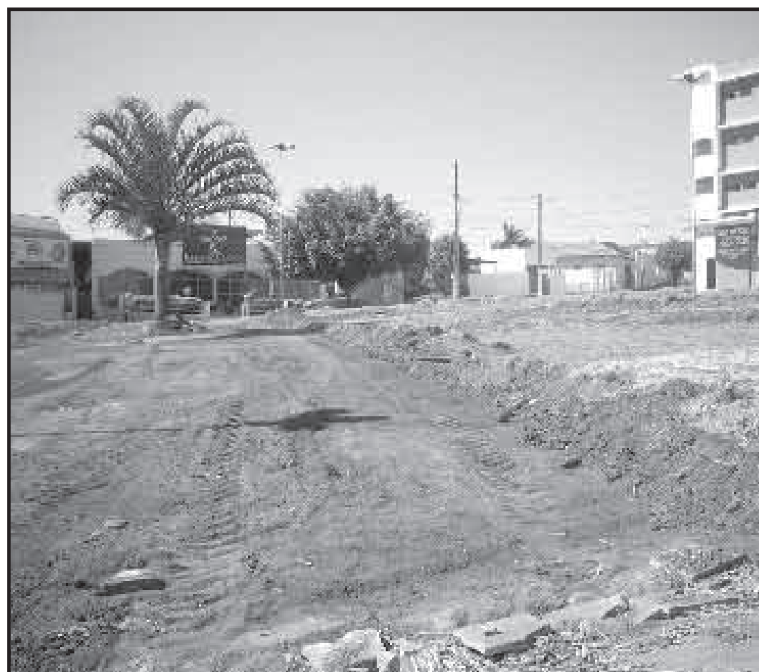
AS OBRAS NA Praça Cônego Trindade estão em fase adiantada e há previsão de entrega para os próximos dias
