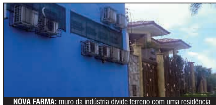
NOVA FARMA: muro da indústria divide terreno com uma residência
